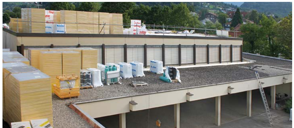
Dachsanierung der Mittelschule Sulz-Röthis
